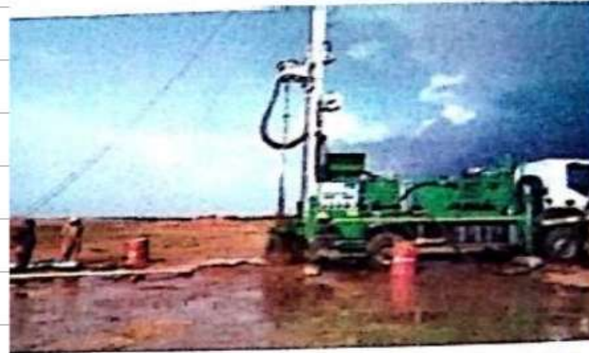
تنقيب في جيب المياه الجوفية العميقة. يتجاوز عمقه 1000 متر
